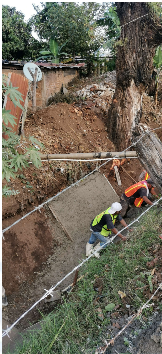
Construcción de pizarras y piso, en canal secundario.
