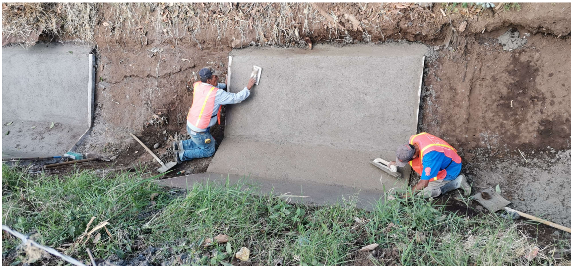
Realización de acabados en piso y pisarras de mejoramiento de canal terciario.
